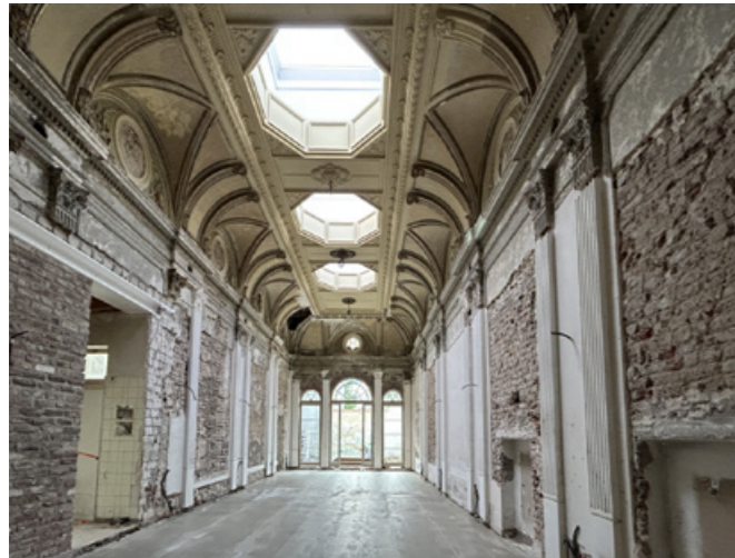
Die Architekten Claudia Schmidt und Holger Brinck sowie der Restaurator Christoph Tölke öffnen die Tür zu einem besonderen Denkmal am Karlsplatz. Bild: privat
