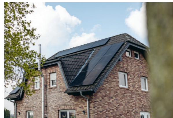
Die Installation einer PV-Anlage auf dem Dach dauert etwa zwei Tage.
