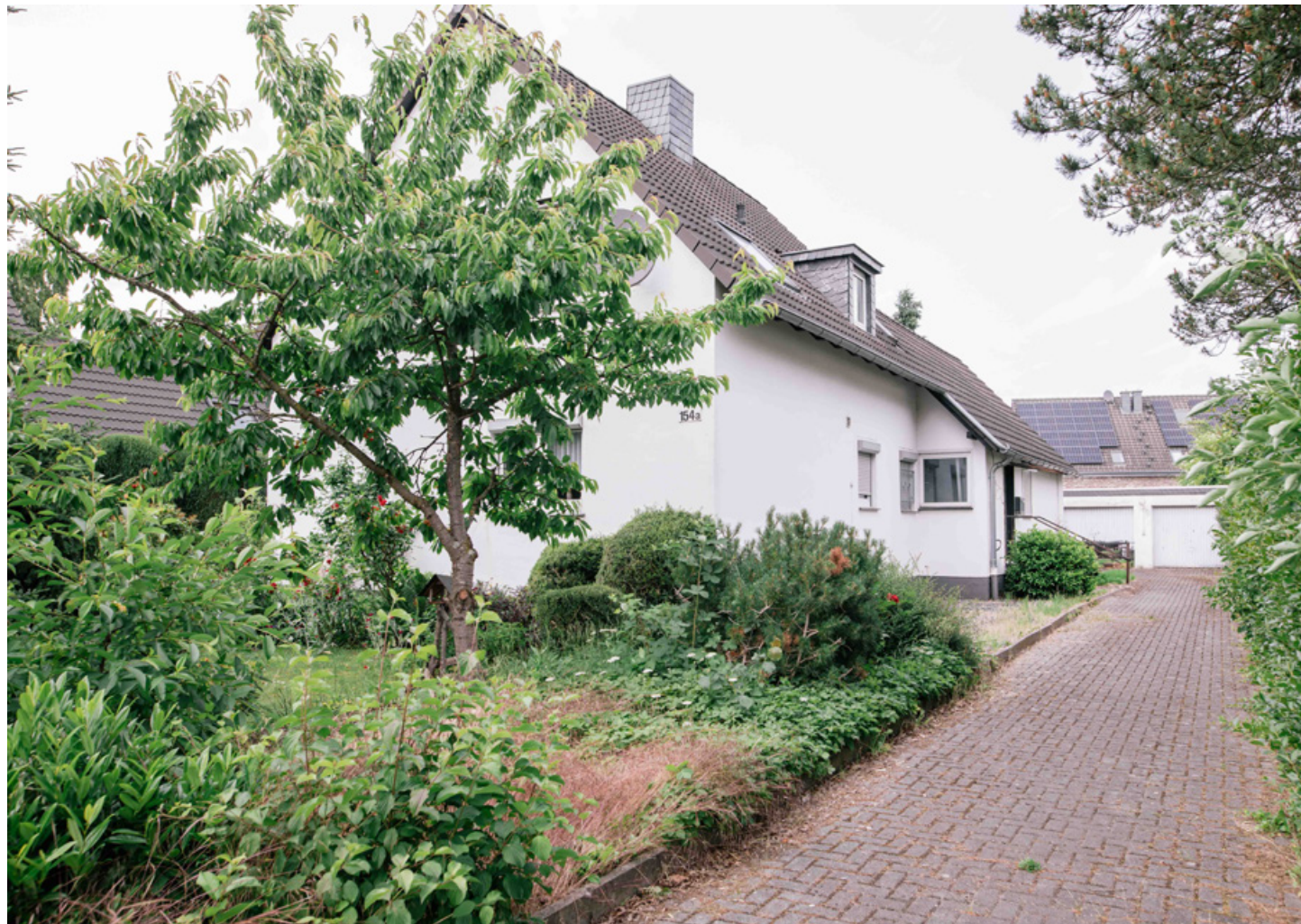
Die sanierte Eigentumswohnung liegt in einem Zweifamilienhaus in Verberg.
