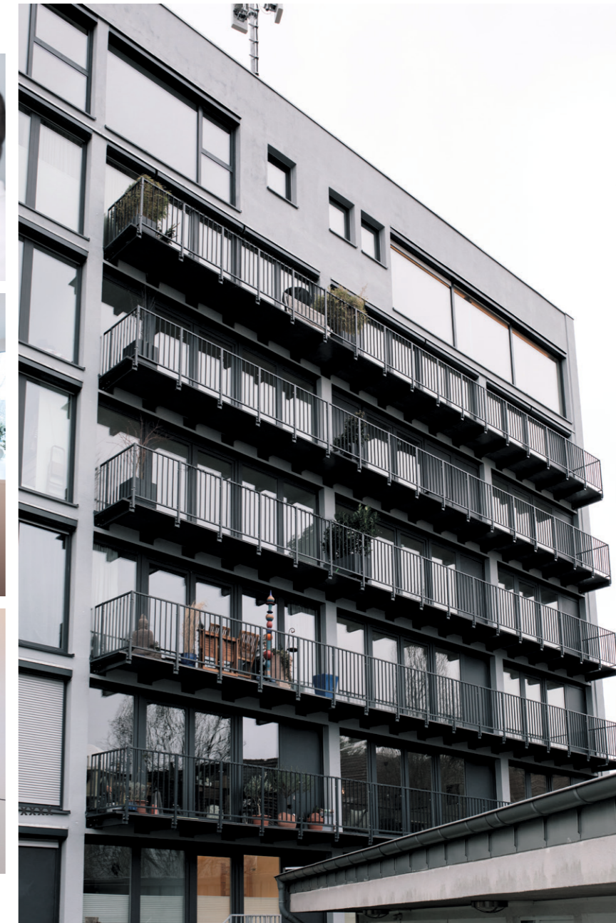
Auch die Außenfassade wurde im Zuge der Umbauarbeiten komplett erneuert.
