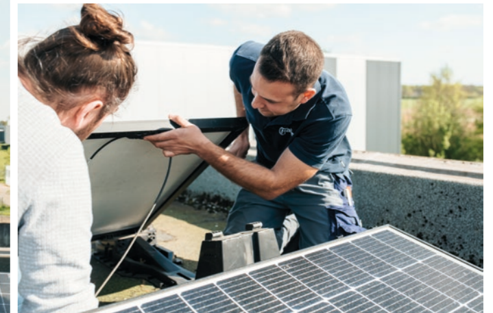
Dachdecker und Elektriker arbeiten Hand in Hand.
